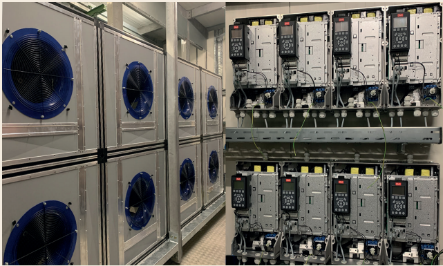
Bild 1: Mehrere Ventilatoren als Fanwall-System mit der benötigten Regelungstechnik. Fotos: Howatherm GmbH
