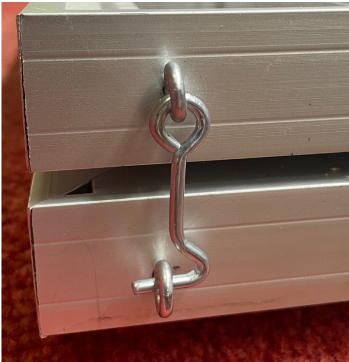
Abbildung 7: Befestigung der Sturmhaken
