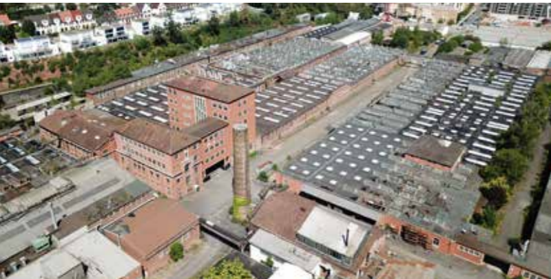
Ehemaliges Pfaff-Werksgebäude in Kaiserslautern
