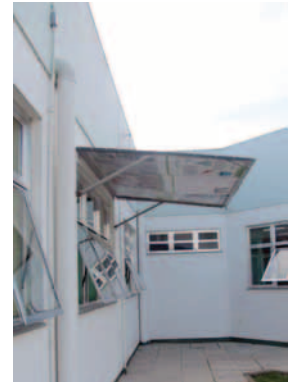
Bau einer Markise als Experiment der AG Energieeffizienz.
